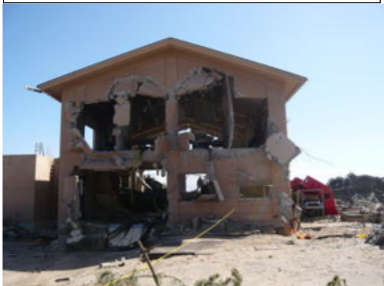
破壊された排水機場(山元町)
