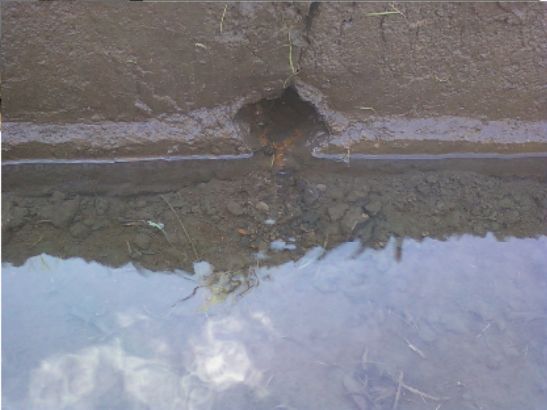
落水状況（弾丸暗渠からの排水）
