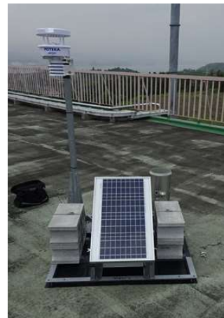
七ヶ浜町役場屋上
