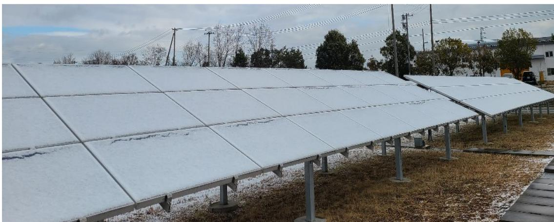
図1：福島再生可能エネルギー研究所（福島県郡山市）における積雪が確認された太陽光発電システム（著者撮影）。
